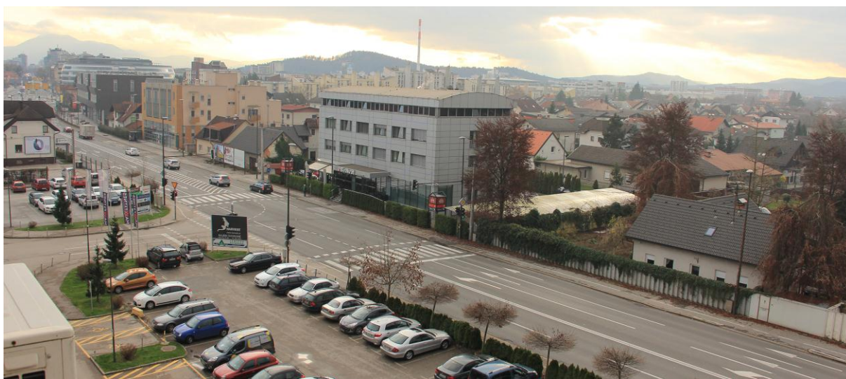
Fotografija 65: Predstavlja izredno nevarno prečkanje ceste, kjer gre za prečkanje več kot dveh voznih pasov in navkljub semaforiziranemu križišču je veliko kršitev vožnje skozi rdečo luč.
