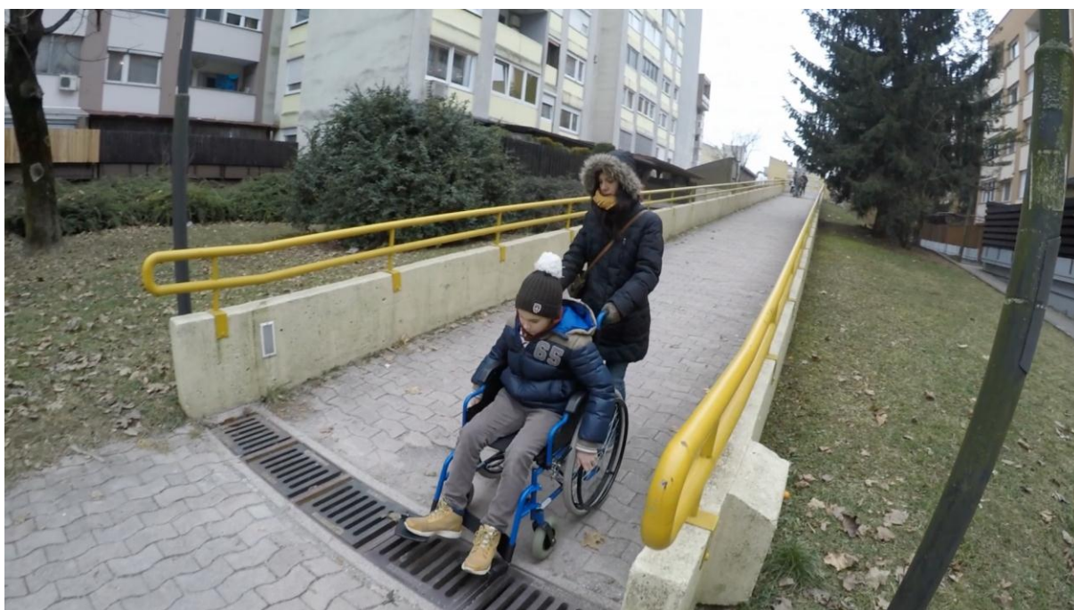
Fotografija 61: Predstavlja gibalno ovirano osebo pri prečkanju rešetk za odvodnjavanje meteorne vode ki deluje kot past za kolesa.
